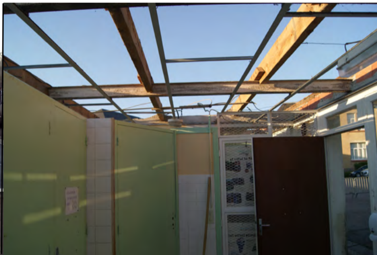
Désamiantage de la toiture des sanitaires de l'école Breton
