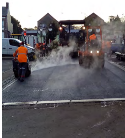
Réfection d'une partie de la place Général de Gaulle
